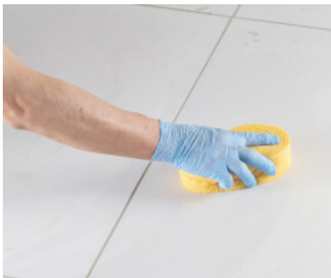
Очищення та фінішна обробка швів жорсткою целюлозною губкою
