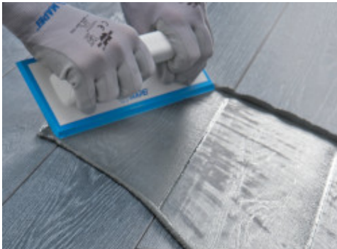
Нанесення Ultracolor Plus гумовим шпателем на облицювання керамогранітом з ефектом дерев'яного покриття
