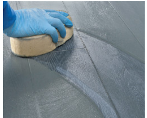
Очищення та фінішна обробка швів жорсткою целюлозною губкою
