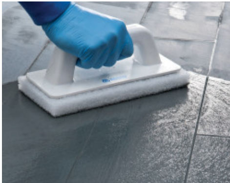
Формування швів губкою Scotch-Brite®, коли матеріал частково затужавів
