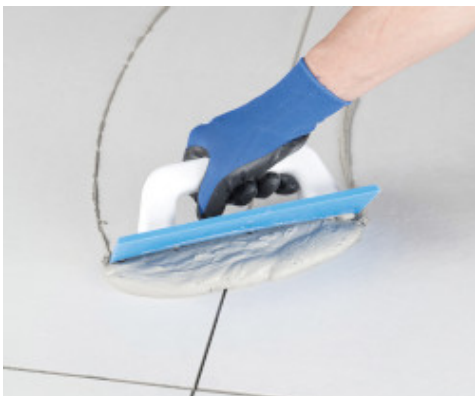
Нанесення матеріалу гумовим шпателем на облицювану підлогу
