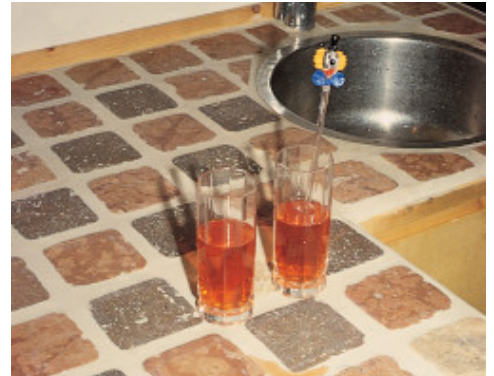
Приклад кухонної робочої поверхні, укладка та заповнення швів виконані матеріалом Kerapoxu
