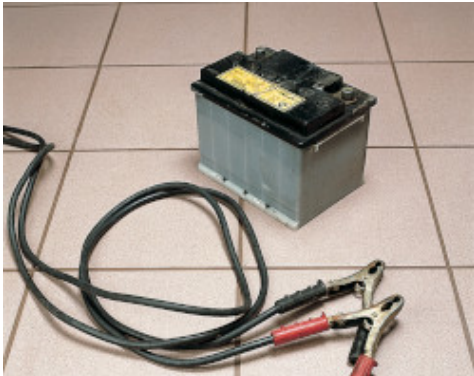
Приклад поверхні акумуляторного залу, шви якої заповнені матеріалом Kerapoxu
