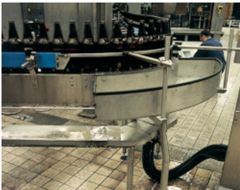
Приклад поверхні підлоги в броварні, шви заповнені матеріалом Kerapoxu
