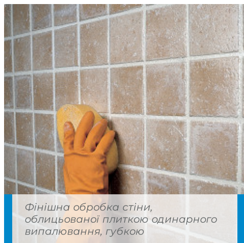
Фінішна обробка стіни, облицьованої плиткою одинарного випалювання, абразивною губкою Scotch-Brite®
