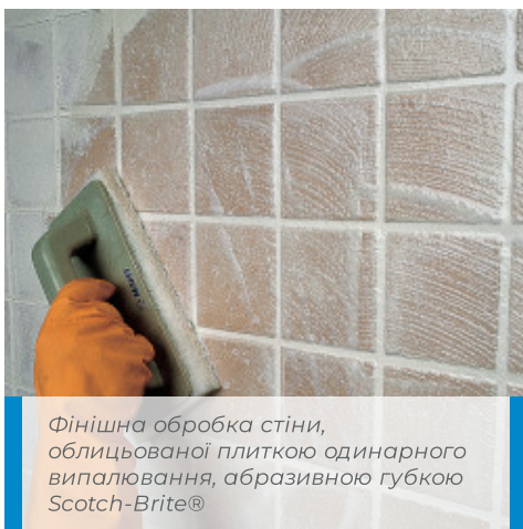
Фінішна обробка стіни, облицьованої плиткою одинарного випалювання, губкою
