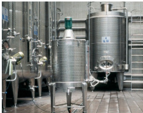
Приклад поверхні підлоги у виноробні, шви заповнені матеріалом Kerapoxu
