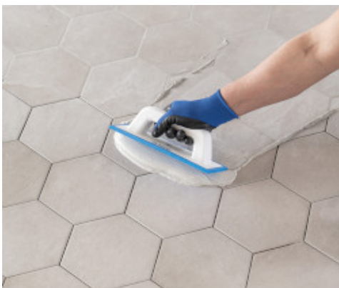
Нанесення Keracolor FF відповідним шпателем MAPEI
