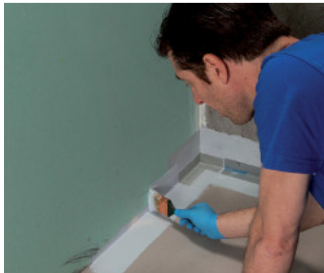
Нанесення Mapeband PE 120, використовуючи Mapegum WPS
