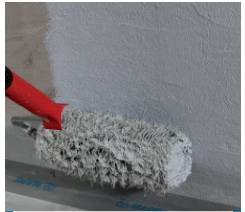
Нанесення Mapegum WPS валиком
