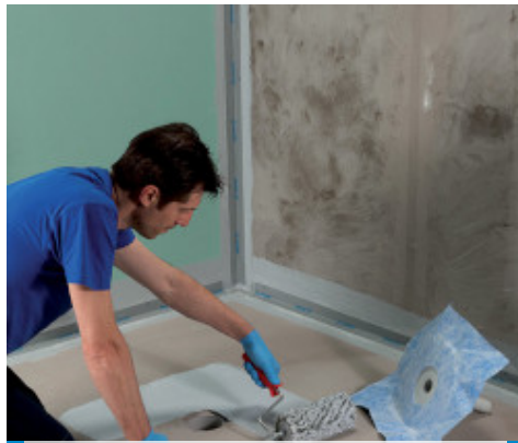
Установка Drain Vertical, використовуючи Mapegum WPS
