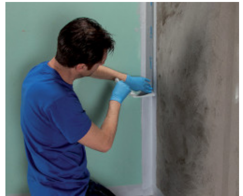
Нанесення Mapeband PE 120 з використанням Mapegum WPS
