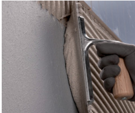
Влаштування підлогового покриття з Ultramastic III
