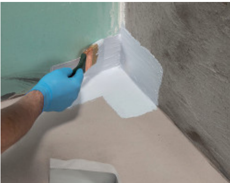
Нанесення на кут 90° кутового Mapeband PE 120, використовуючи Mapegum WPS
