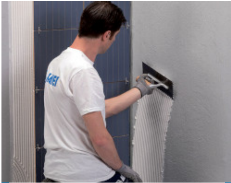
Влаштування настінного покриття з Keraflex Maxi S1
