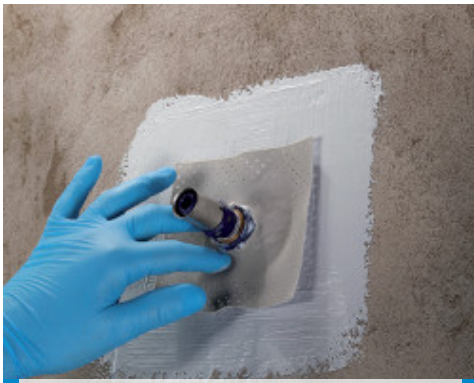
Нанесення Mapeband PE 120 для герметизації прохідних отворів, з Mapegum WPS
